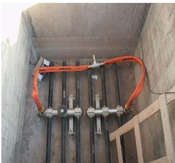
Figure 2 : Raccordement des raquettes de diffuseurs.
