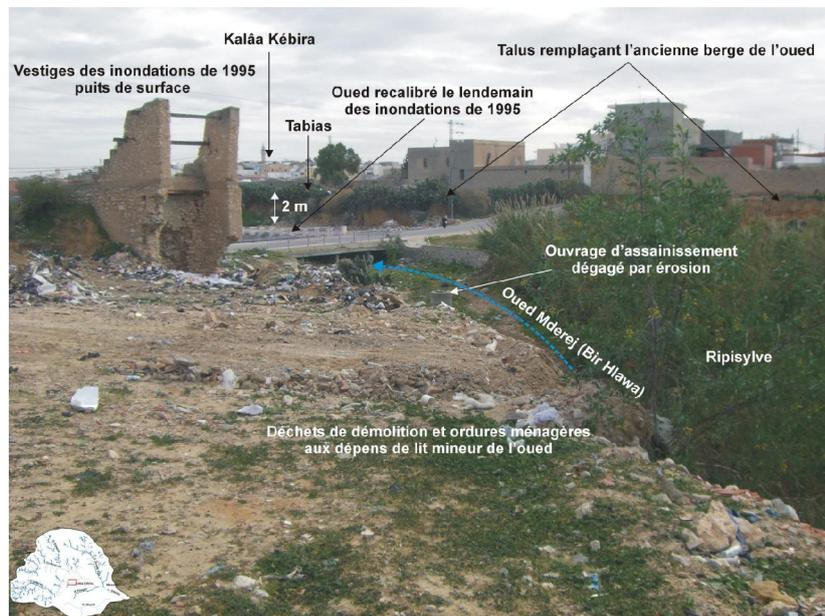
**Figure 9.** La photo illustre les risques auxquels sont exposées certaines constructions situées à proximité du lit mineur des différents oueds qui traversent Kalâa Kébira (ici l'oued Bir Hlewa). Théoriquement, les rives des oueds ne devraient pas être urbanisées, mais leur situation sur un front d'extension urbaine en fait des zones très prisées.
