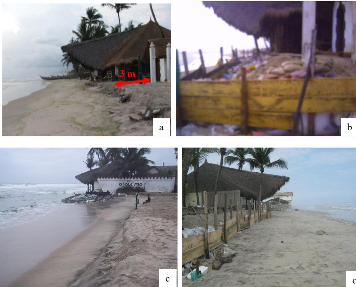
**Photo 2:** Erosion à la station «O Sole Mio» a et c) Le talus d'érosion se rapproche des installations touristiques en août 2009 et septembre 2011, b et d) essai de protection de la clôture de cet espace touristique (Octobre 2010 et septembre 2011).
