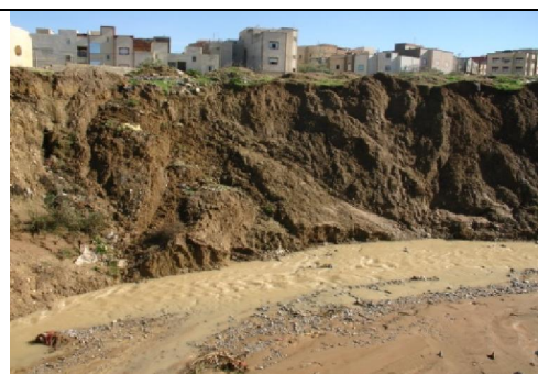
Figure 5 : Constructions, érigées sur des terrains marneux en pente menacés par les inondations et les mouvements de terrains. (périphérie nord de Taza - rive droite de l'oued Larbâa).
