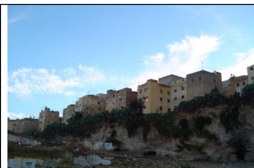
Figure 4 : Paysage chaotique de constructions en hauteur surplombant des falaises de travertin. Des effondrements liés aux écroulements de falaise sont assez fréquents (Zone périphérique au nord de Fès).
