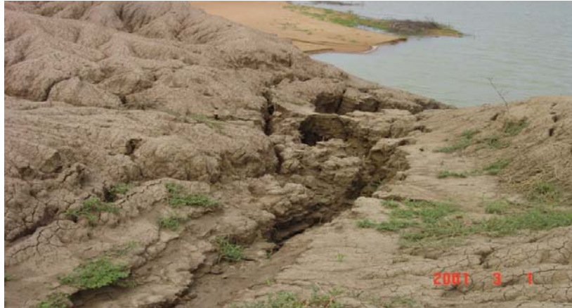
Photo 3 : Terrasses soumises au ruissellement des eaux ayant pour conséquence des ravines qui échancrent leurs différents versants provoquant des croutes de battance par endroits (cliché, DOUDJE, 2006).
